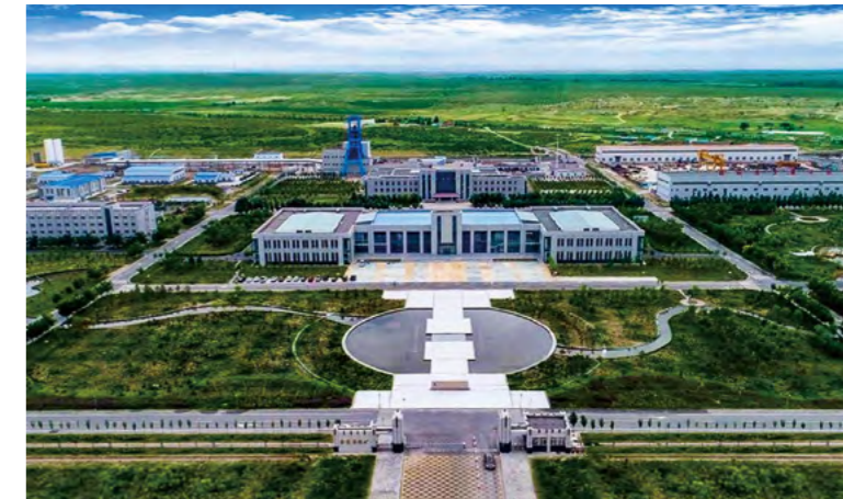
治理后的金家渠矿外景
