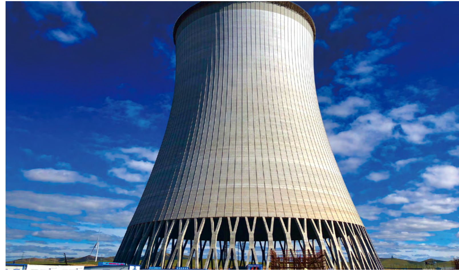
国能胜利电厂实现冷却塔“烟塔合一+五塔合一”技术新突破，且排放标准达到“112”超超低排放指标
