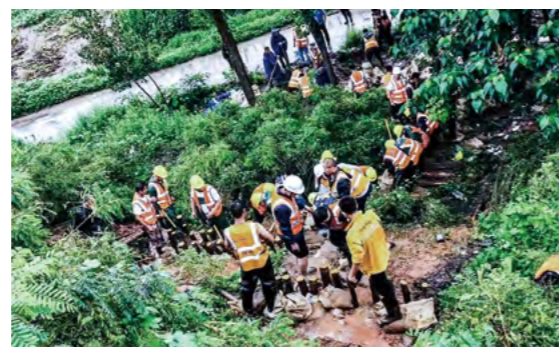
参加水害造成的边坡溜塌抢险行动
