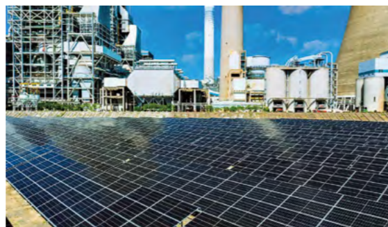
浙江公司宁海电厂光伏项目
