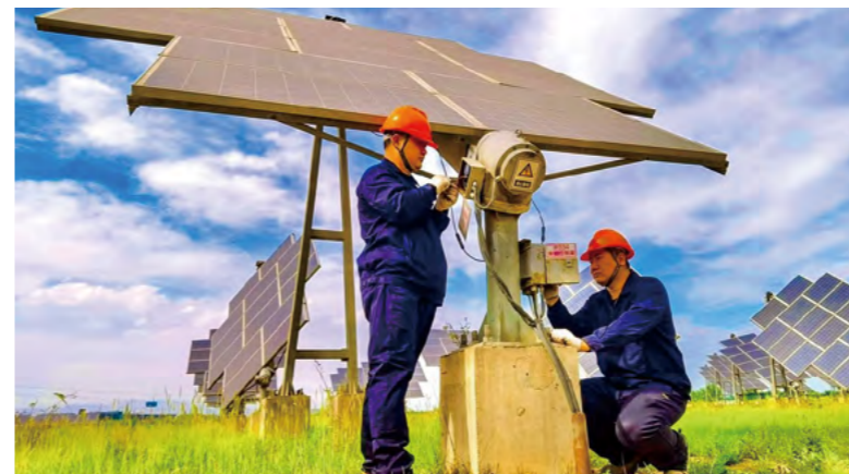
国电电力宁夏新能源调整维护电池板伺服系统
