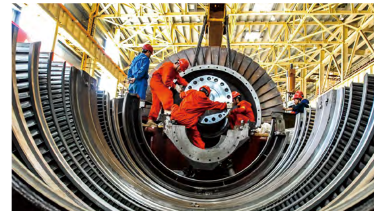
浙江公司北仑电厂生产人员进行汽轮机叶片检修
