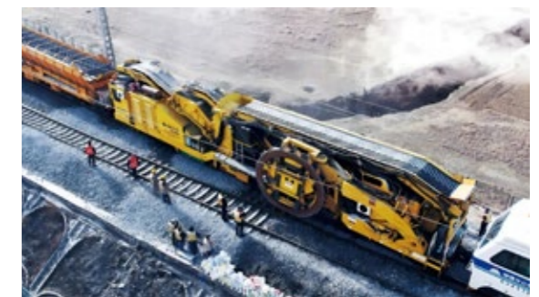
铁路装备公司首次实现了单线隧道机械化清筛作业，填补了国内空白
