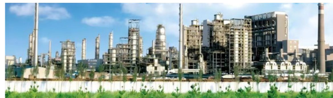
建成一批煤直接液化、煤制烯烃、煤间接液化、煤基聚乙醇酸（PGA）国家级示范工程（图为神华百万吨级煤直接液化项目）
