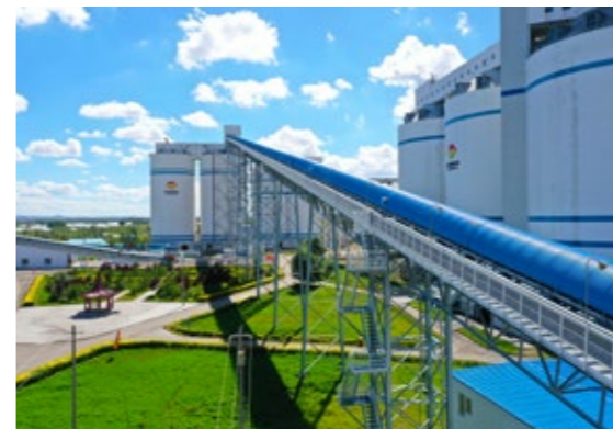
国能胜利电厂 1 号机组采用“两机一塔、五塔合一”技术为世界首创，高水份褐煤大功率等离子点火技术填写了国内技术空白
