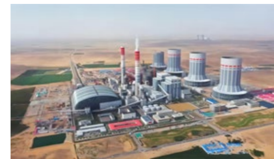
国电电力上海庙公司首次实现了全国自主可控智能分散控制系统 (iDCS) 在国内 100 万千瓦超超临界大型燃煤间冷机组上的成功应用
