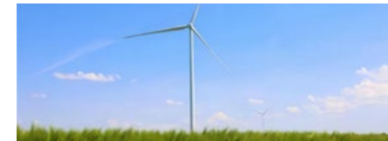
乌克兰尤日内风电项目
