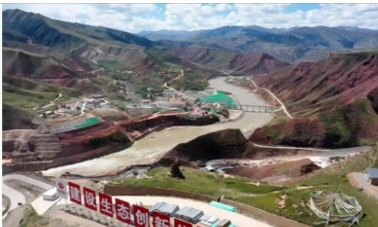
千万千瓦级多能互补清洁能源一体化基地——青海玛尔挡“水光蓄储”项目
