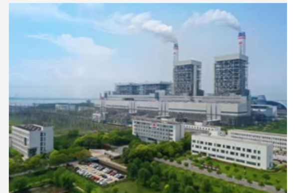
泰州公司电厂
