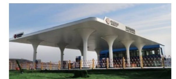
万全油氢电综合能源站
