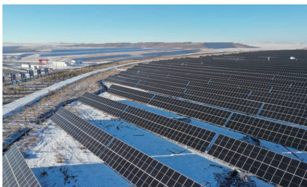
胜利能源露天矿排土场光伏项目
